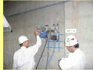
コアボーリングの状況
